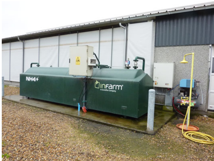
Gylleforsøringsanlæg fra Infarm der kan regulere pH i gødningen
